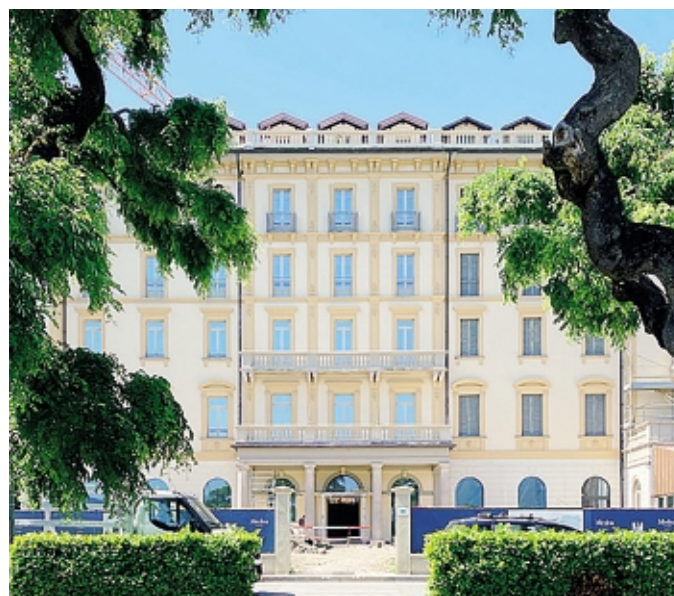
L'ingresso del Grand Hotel Victoria durante i lavori
